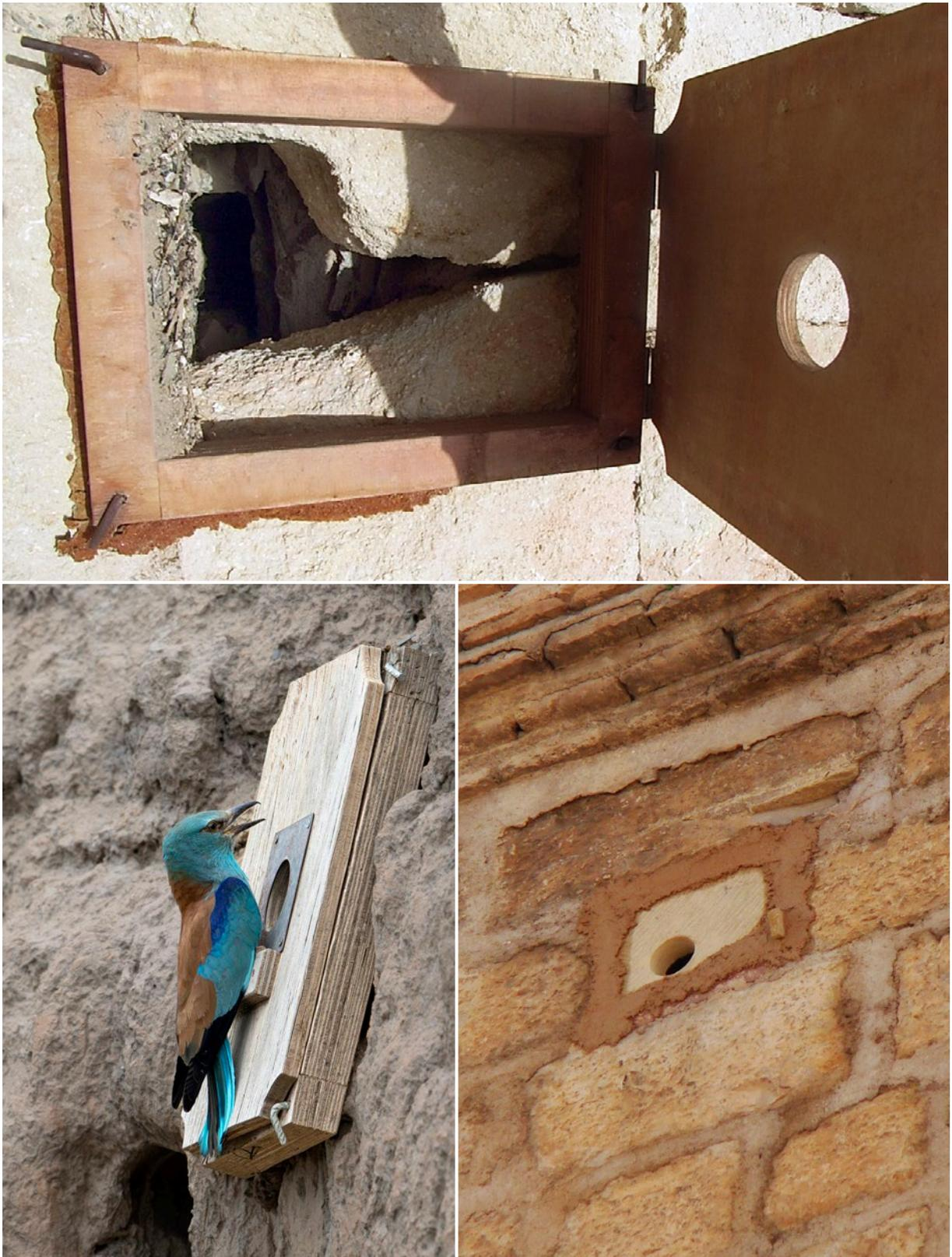
**Imagen 65.** Adaptación de cavidades naturales y en construcciones humanas para especies trogloditas: a) colocación de tapaderas en mechinales de puentes (Uleila del Campo, Almería) (Autor: Francisco Valera), b) carraca en oquedad de talud adaptada (Tabernas, Almería) (Autor: Manuel Gómez @manuelgomezwildlife), c) tapadera en mechinal de edificio (Jaén) (Autor: Francisco Pulpillo-SIECE).
